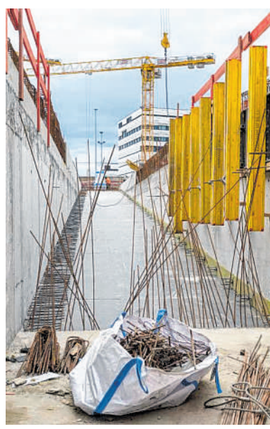
Die Rampe in die Radgarage ist schon fast fertig.
